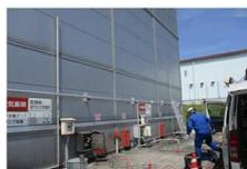
毎月、業者によるLPG設備点検や、年1回の地下タンク漏洩検査(灯油・アルコール)を実施。消耗品交換や、不具合が発生した場合、すぐに対応を行っている。
