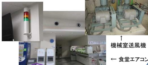
デマンドシステムと連動しているアラートが鳴動すると、使用量の大きい食堂空調を停止させた。契約電力を27kW減らしたが、超過を防ぐことができた。
