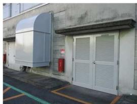
外気を取り入れるダクトと出入口扉に遮熱塗装をした。夏場に高い外気温の空気を抑えることで機械の負荷を低減させ、異常停止の抑制に努めた。
