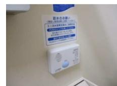
流水音発生器設置。25秒間音が流れ、節水が可能に。
