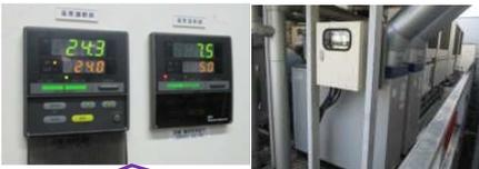
直前にボイラーを稼働させ、不要な場合は都度停止させる取り組みを行った。また、給気温度設定を10℃下げた。灯油使用量と経費の大幅な削減となった。
